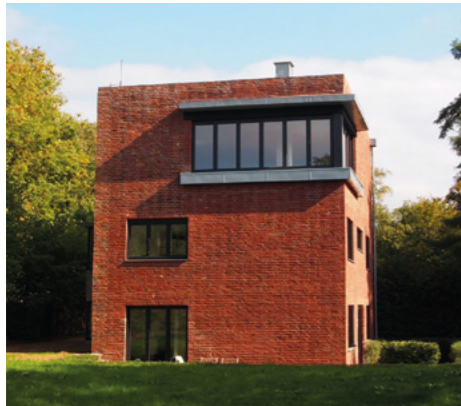
Abb. 3: Karl Meinhardt (Architekt), „Haus Kaesbach“, Düsseldorf-Lohausen, Zustand 2013
